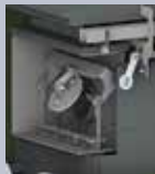
Rauchgasklappe geöffnet
