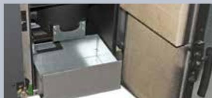
Der HDG Hydraulikadapter ermöglicht die einfache Installation von Vor- und Rücklauf innerhalb der Kesselverkleidung. Die hydraulischen Anschlüsse können so einfach nach Oben, Links und Rechts (von hinten gesehen) geführt werden.
