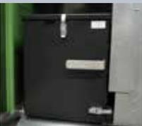
Der **Edelstahl-Brennertopf** mit vollautomatischer Brennertopfentaschung sorgt für eine hohe Betriebssicherheit bei niedrigem Pelletverbrauch. Die automatische Zündung über keramische Heizelemente ermöglicht einen schnellen, effizienten Betriebsstart. Die integrierte Sekundärluftführung mit optimaler Luftvorwärmung sorgt für niedrigste Emissionswerte.
