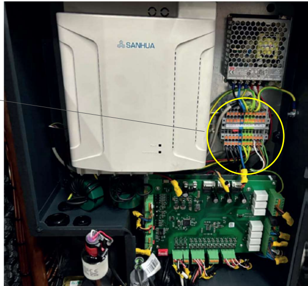
Abbildung 4/38 - Verdrahtungsschema Wärmepumpe - Spannungsversorgung
