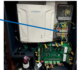
Spannungsversorgung Wärmepumpe
