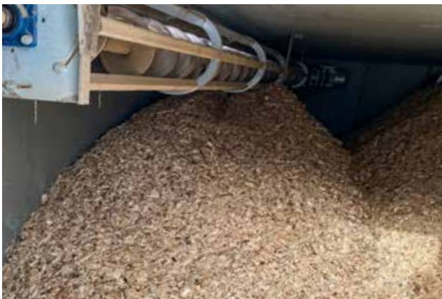
Das Einbringsystem nutzt den Lagerraum fast bis zur Decke
