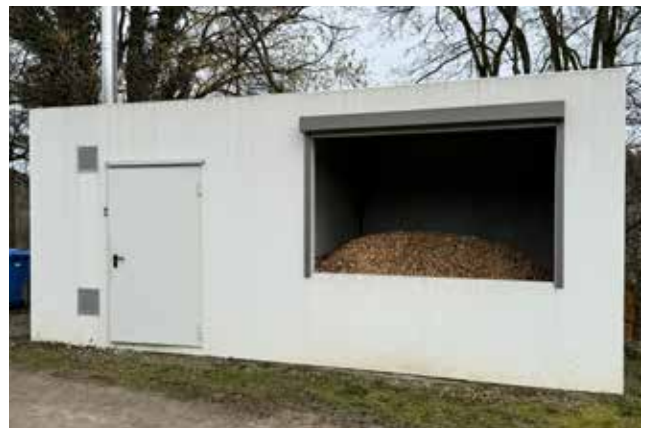
Die Alternative: Befüllung des Lagers von der Seite
