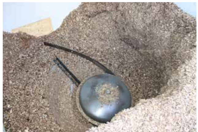
Hackschnitzellager: Befüllung mit Frontlader, Volumen ca. 15 m 3
