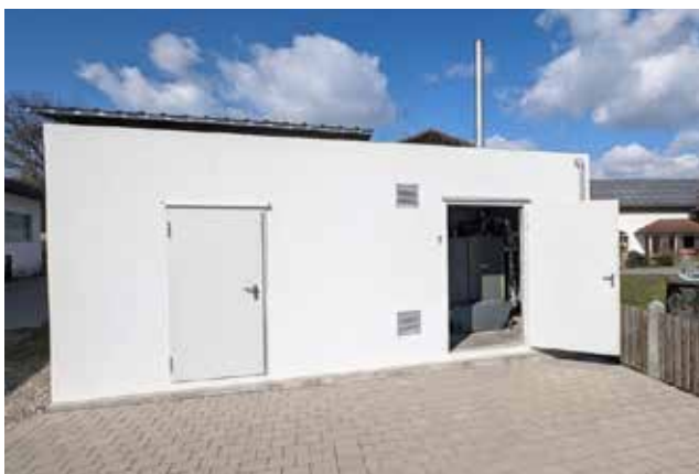
Die Heizbox bietet Platz für die komplette Kesseltechnik...
