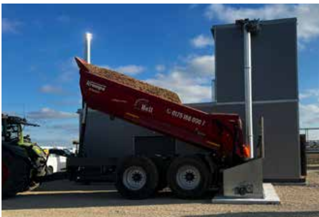
Befüllung mit Hackgut über das Einbringsystem
