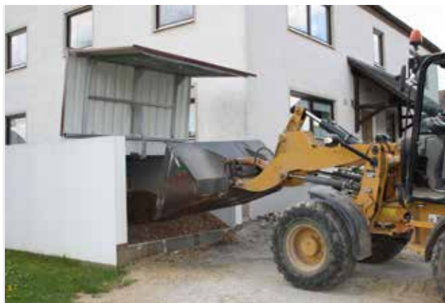
Heizbox 1,3 m im Boden versenkt für einfachste Befüllung
