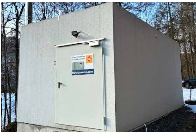
HDG Heizbox mit Befüllung von oben via Telesklader
