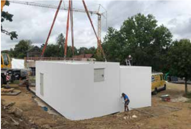
Die Heizbox wird mittels Autokran montiert
