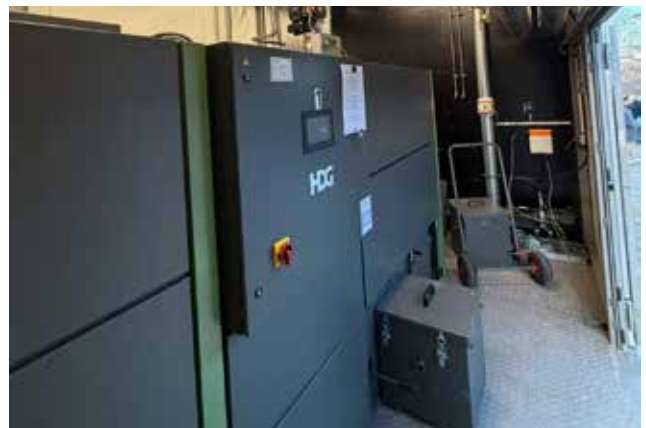
Innen finden 240 kW Leistung samt Pufferspeicher und Zubehör Platz
