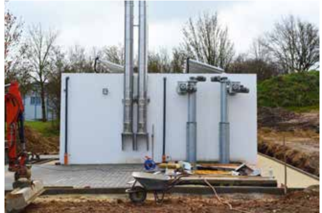
Fundamente für Heizbox und Einbringsystem wurden vorbereitet
