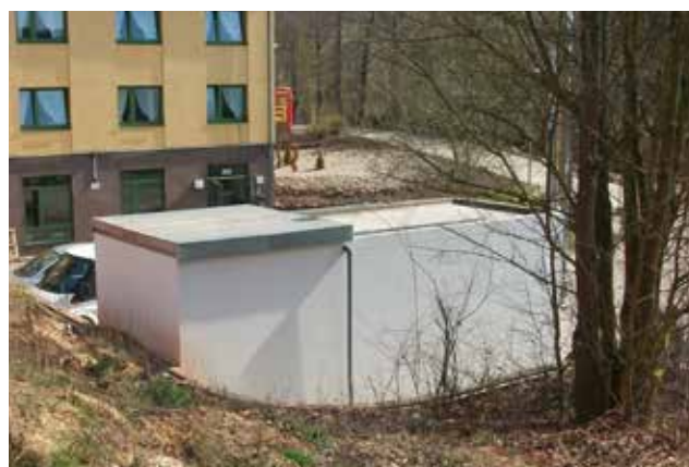
Die Hanglage vereinfacht die Befüllung
