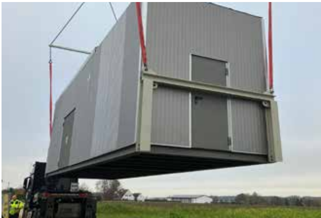
Mittels Kran wird die Heizbox auf das Fundament gehoben
