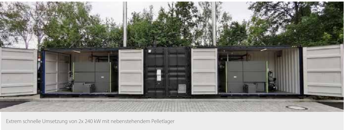
Bauseitig umgebaute Überseecontainer wurden zu einer 1.200 kW Heizzentrale
