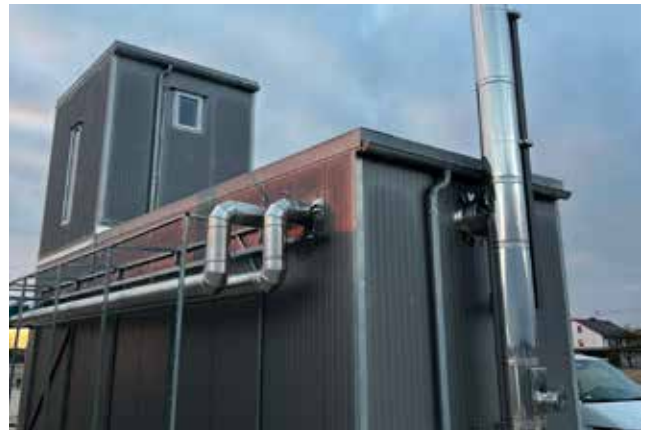
Kamin und hydraulische Anschlüsse werden vor Ort ergänzt
