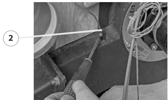
Abbildung 4/15 - Schrauben und Abgastemperaturfühler entfernen
