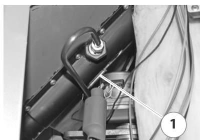
Abbildung 4/23 - Fühler Sicherheitsthermostat einbauen
