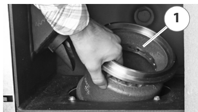
Abbildung 7/9 - Konus-Unterteil herausnehmen
