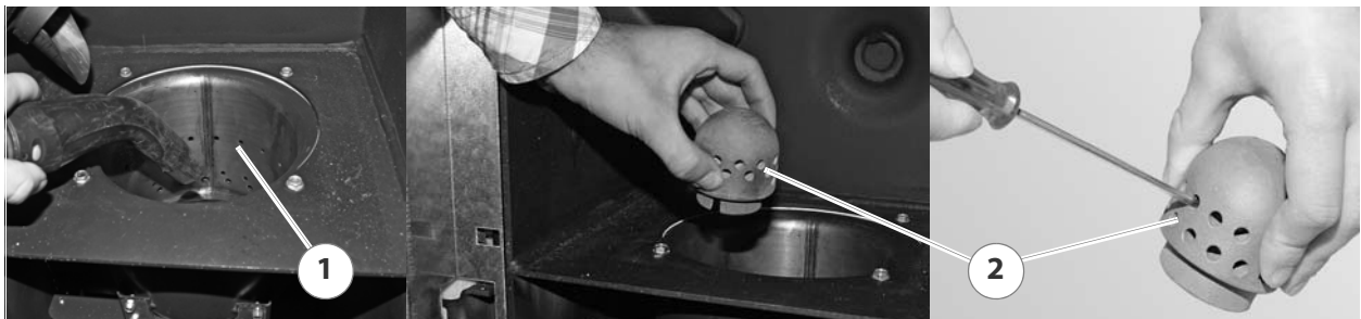
Abbildung 7/11 - Brennerkopf und Primärluftdorn reinigen
