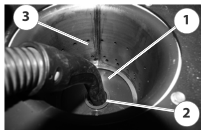
Abbildung 7/12 - Primärluftrohr reinigen
