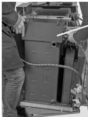
Abbildung 4/17 - Abgaswärmetauscher wegheben
