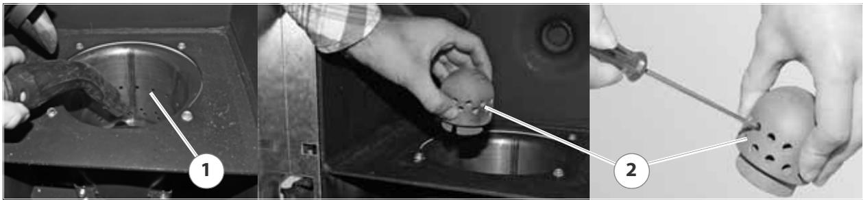
Abbildung 7/14 - Brennerkopf und Primärluftdorn reinigen
