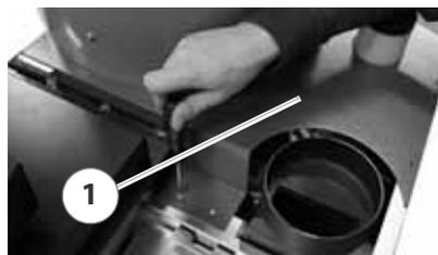
3. Setzen Sie die obere Verkleidung (1) über den Wasserbehälter auf den Kessel.
